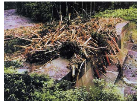
流木捕捉式治山ダムの設置
