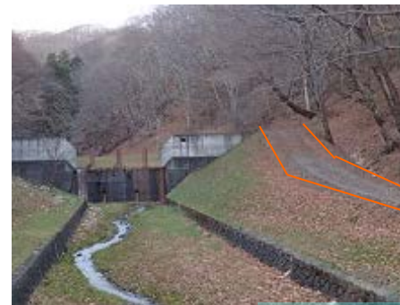
管理道の設置
