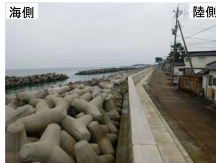
堤防嵩上げによる越波の防止
