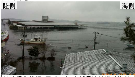
津波侵入状況(平成23年 宮城県渡波漁港海岸)
