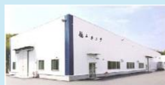
倒壊した工場・施設等の復旧支援
