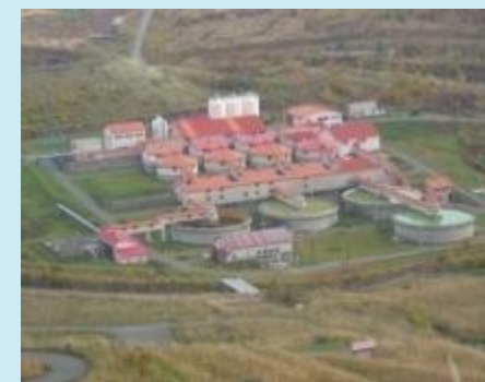
（坑廃水処理施設の例）
