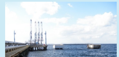
※ 製品出荷棧橋の土台
